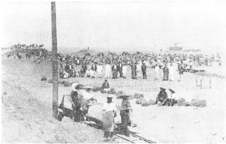
グラウンド整地工事（大正十二年）
