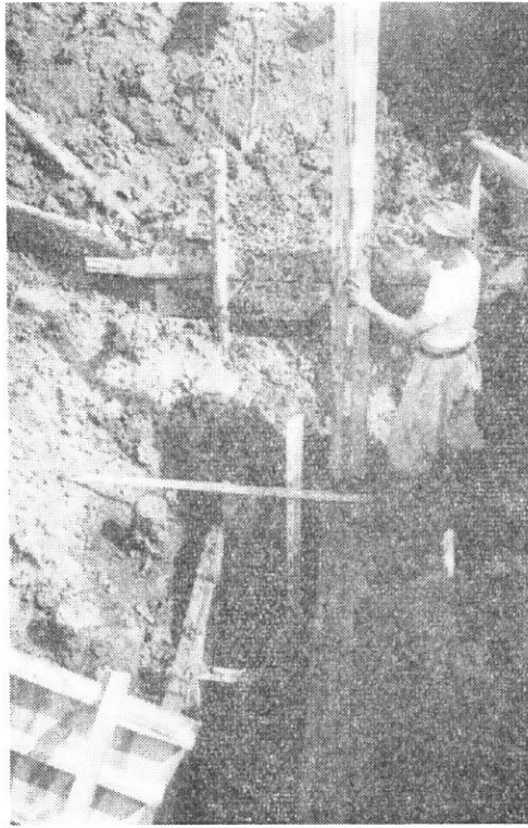
柏農校付近の改修工事
